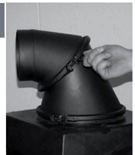
Kuva 5b Asennus taakse
